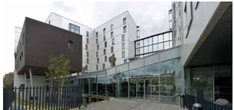
Maison Internationale du Séjour. Résidence hôtelière de 144 logements, résidence étudiante de 198 chambres, un foyer jeunes travailleurs de 86 logements - 1 500 m 2 d'espace communs - 13 800 m 2 - Paris (13 ème ) Etudes 2012 - Livraison 2016
