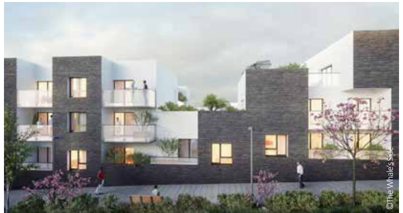
131 logements dans un écoquartier à Chambry-lès-Tours (chantier en cours – 2019)
