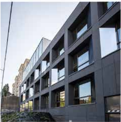
Réhabilitation bureaux à La Madeleine (59)
