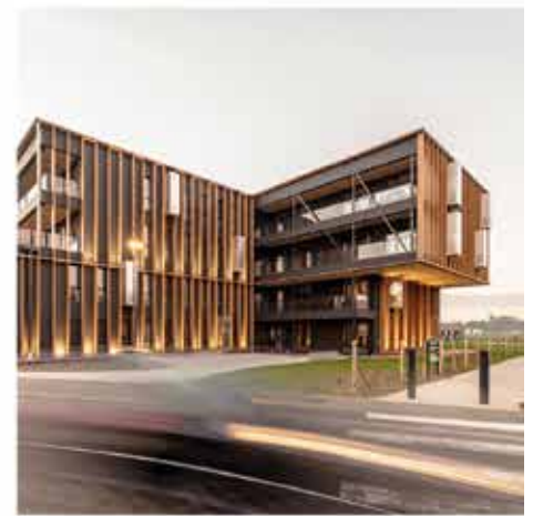
Bureaux aéroport de Bondues (59)
