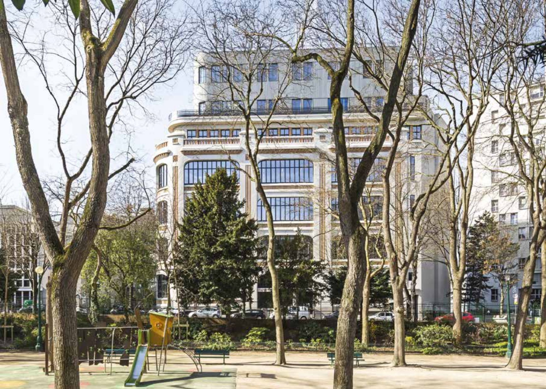
Restructuration d'un immeuble de bureaux, Paris (75) - Foncière des Régions et Orange © Sergio Grazia
