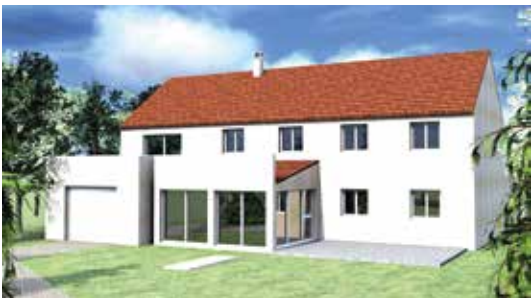
Construction d'une maison individuelle au Meriot (10), 2019
