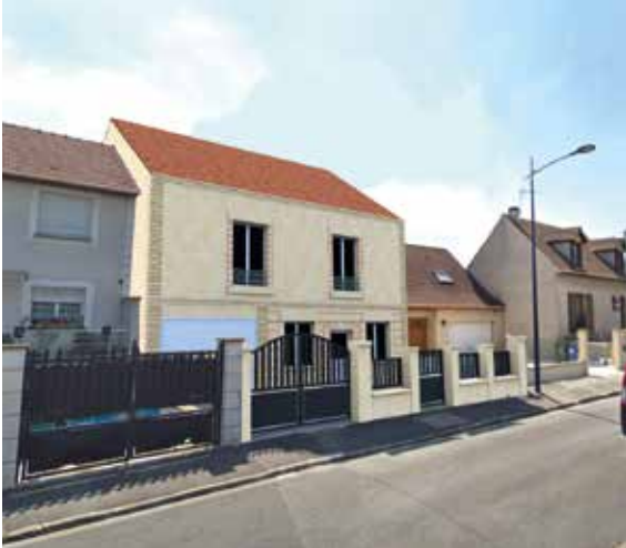
Construction d'une maison individuelle à Drancy (93), 2019
