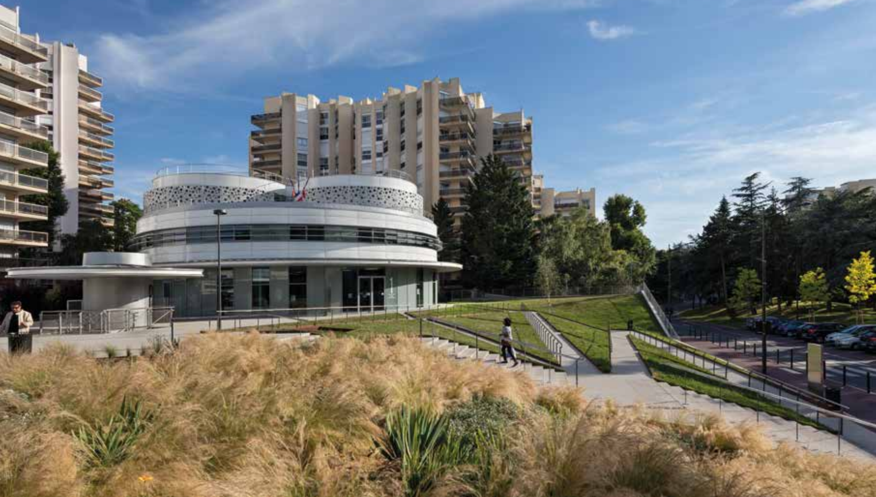
La restructuration d'un urbanisme de dalle - Saint-Germain-en-Laye (78)
