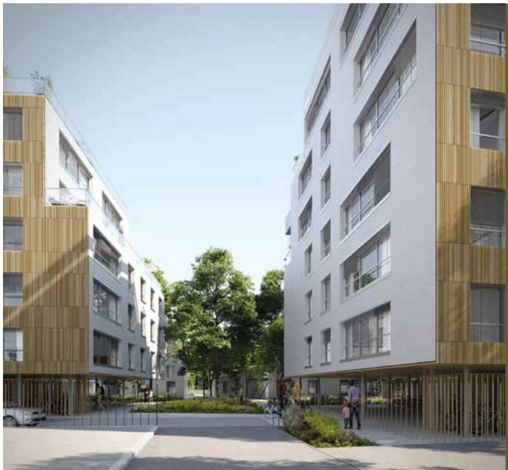
110 logements à Achères (78)
