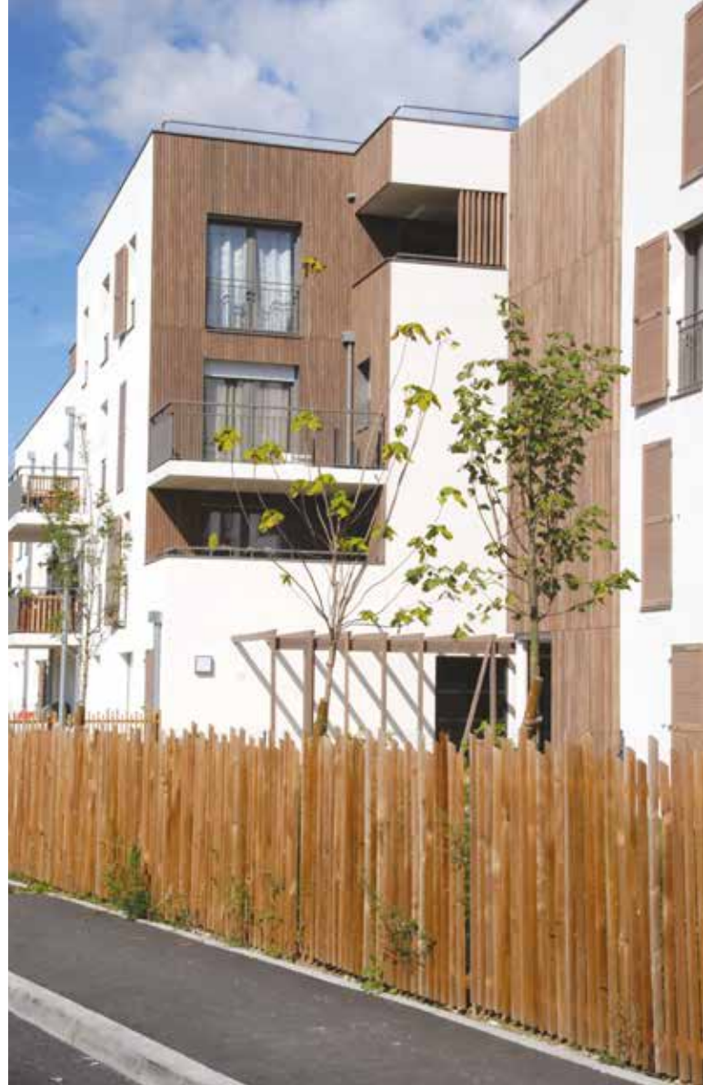
53 logements pour Groupe Arcade à Bessancourt (95) - ZAC des Meuniers
