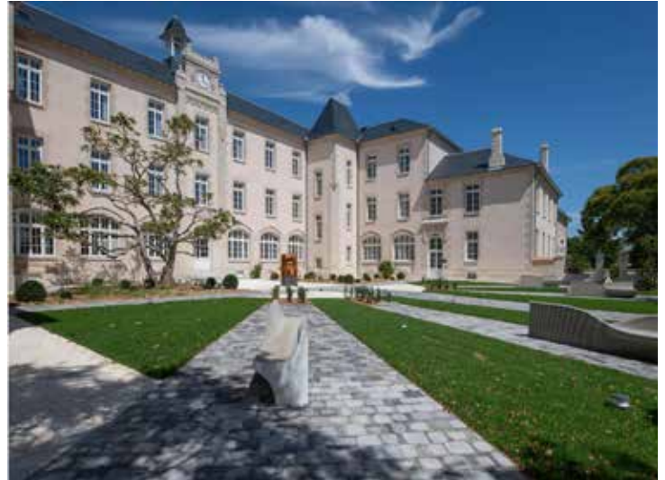
Prix National 2019 – Trophées de la Construction Batiactu - Rénovation de Logements Collectifs – La Rochelle (17)
