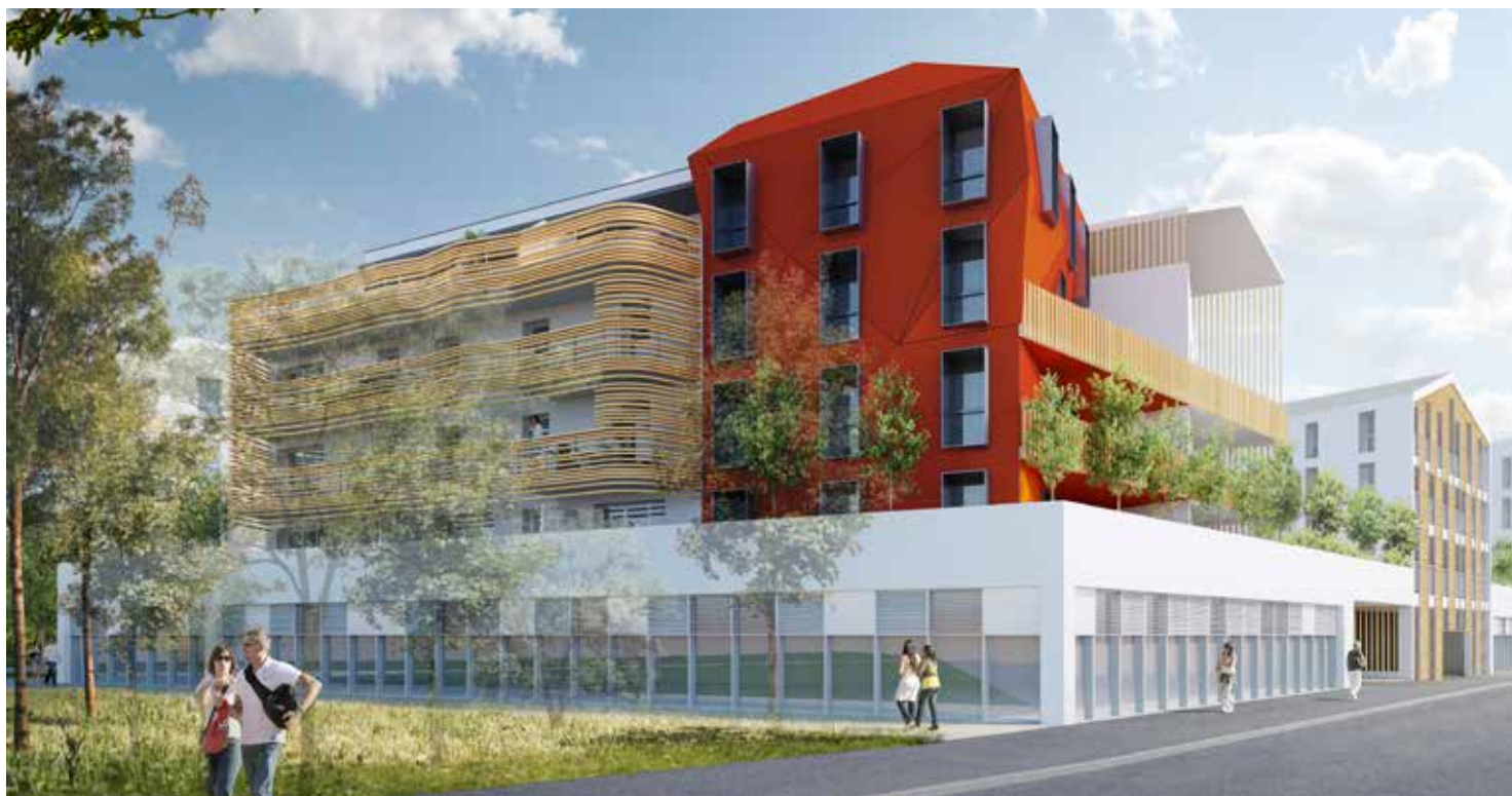
115 Logements et 1 500 m 2 de bureaux - La Rochelle (17)
