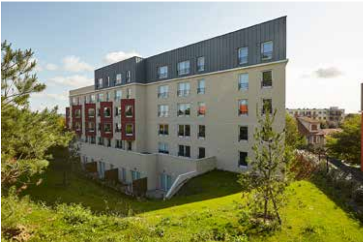
Les Résidentiales – Immeuble de 98 logements – Camar Finance © Aleksandre Pinel
