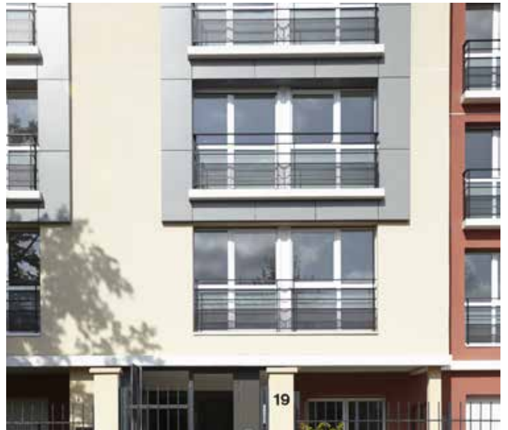
Les Résidentiales – Détail façade – Camar Finance © Aleksandre Pinel
