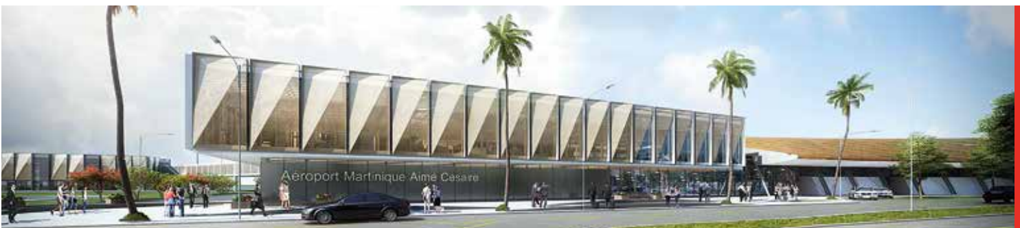
Aéroport Aimé Césaire à Fort de France (97)
