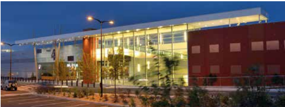
Centre commercial à Mérignac (33)
