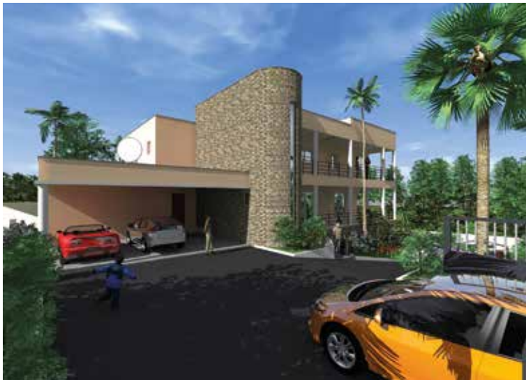
Etude et réalisation d'une résidence privée (Particulier), Libreville. Surface : 400 m 2
