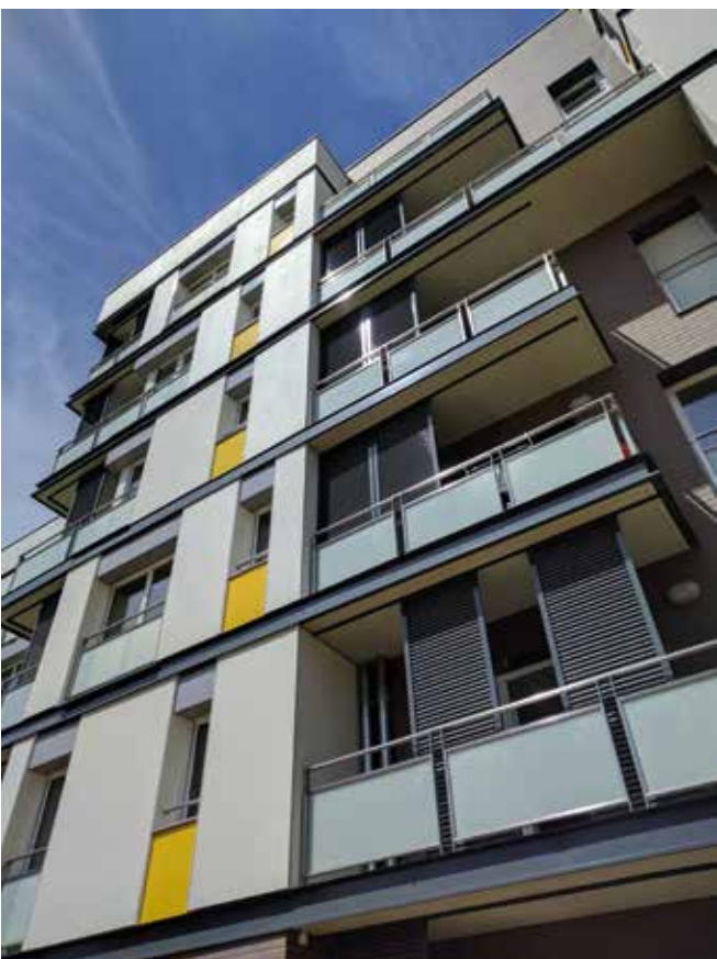
315 logements, Chaperon Vert, Gentilly (94), OPALY, Réhabilitation, livraison fin 2018
