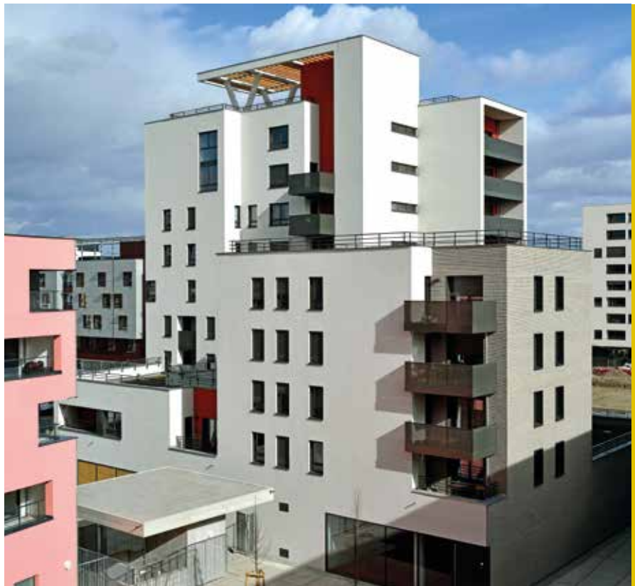
Construction d'une résidence de 35 logements collectifs sociaux et commerces à Strasbourg (67)
