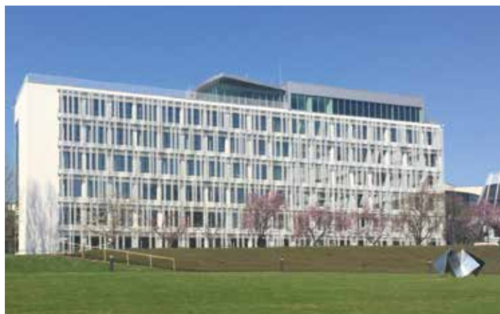
Restructuration du bâtiment Vaclav Havel et construction d'une passerelle de liaison sur le site du Parlement Européen à Strasbourg (67)
