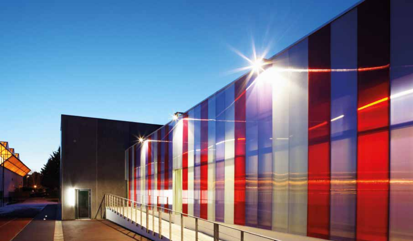
Construction du stade Jean-Louis Moulin à Evry (91), 2013
