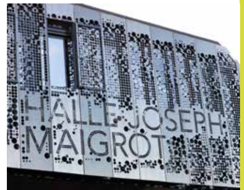
Rénovation de la Halle Maigrot à l'Insep Paris (75), 2016
