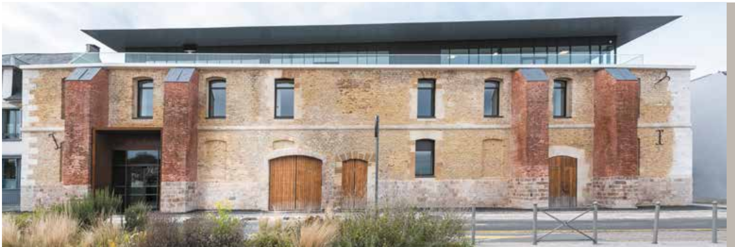
Complexe culturel, associatif et de tourisme – Saint-Valery-sur-Somme (80) – Le passé (re)composé de l'entrepôt des sels – Maîtrise d'ouvrage : Ville de Saint-Valery-sur-Somme
