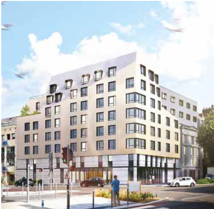
Résidence Universitaire CROUS – Rouen (76) – Un jeu de lignes brisées comme réponse urbaine de qualité – Maîtrise d'ouvrage : Quevilly Habitat
