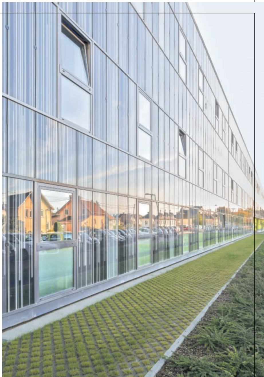
Restructuration et extension de l'hôpital de Pfstatt, France.
