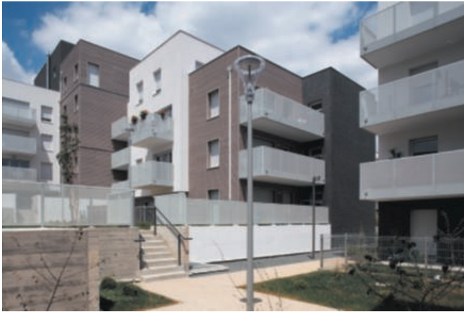
Pavillons-sous-Bois - 75 logements BBC, France.
