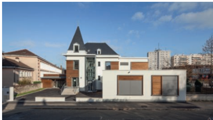
Extension et réhabilitation d'un espace jeunesse à Poissy, 2014.
