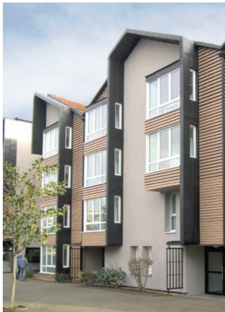
Ris Orangis – Résidence Eglise. Réhabilitation de Logements sociaux.
