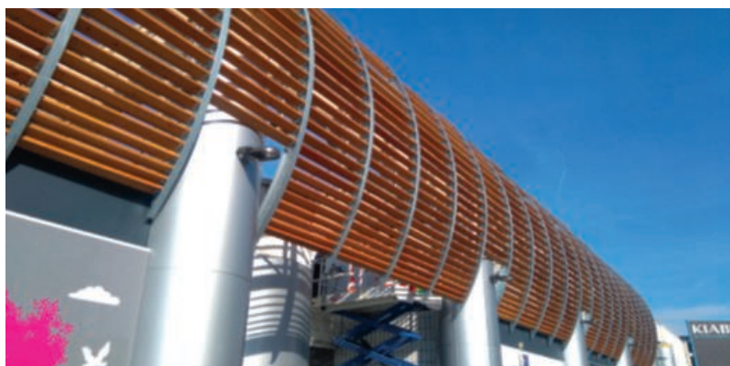
Auchan Val de Fontenay. Renovation de la façade du Centre Commercial.
