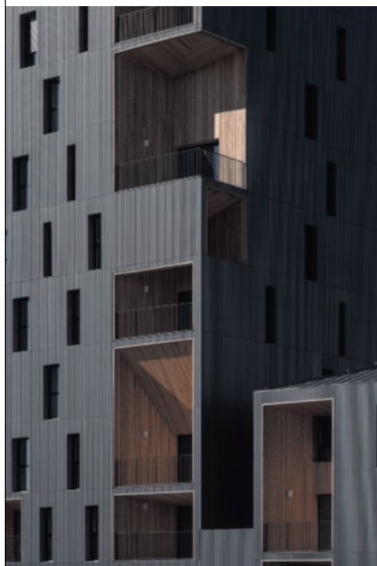
«Concert'Ô» - îlot Citram, Bassins à Flot - Bordeaux (33). 4 095 m2 SDP résidence intergénérationnelle thématique : 52 logements dédiés à la résidence dont 24 séniors et 28 familiaux. Maître d'Ouvrage : Icade Promotion.
