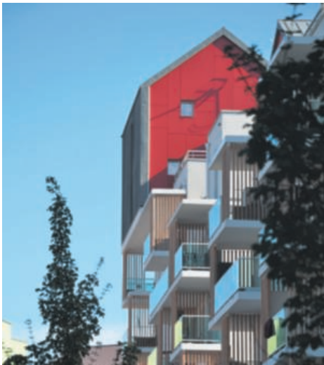
93 logements + commerces – Limeil-Brevannes (94).
